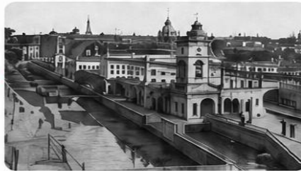
Proceso de canalización y urbanización
